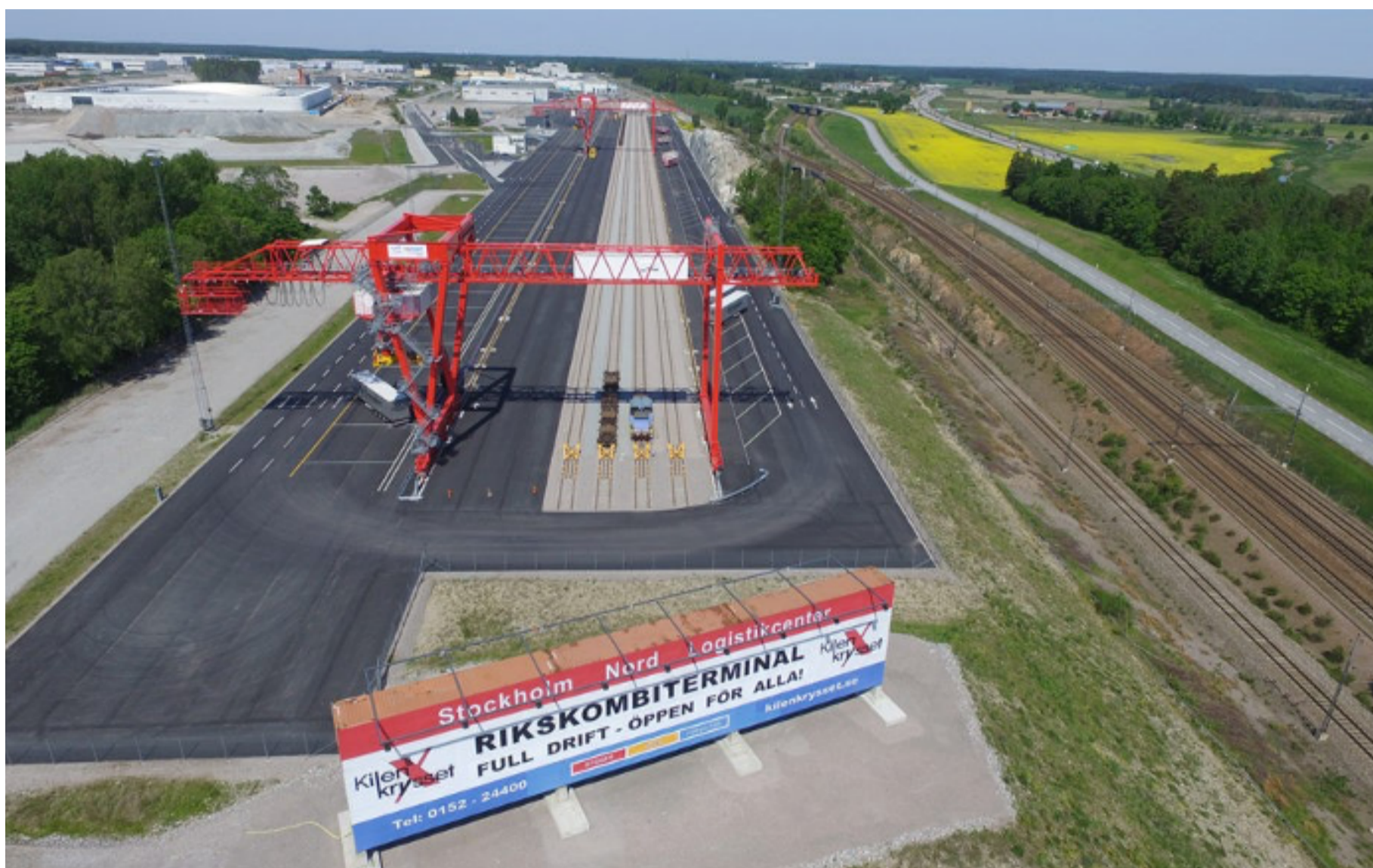
Bild: Foto över Rikskombiterminalen i Rosersberg (Stockholm Nord Kombiterminal). På bilden syns järnvägsspår tillsammans med logistikutrustning för på- och avlastning samt övrig byggnad i bildens borte del. Till höger syns stambanan som är trafikerad av såväl passagerar- som godstrafik.
